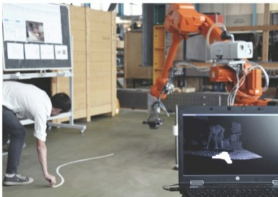
MOCK Digital Fabrication Innovative Building Processes in Architecture Bernier Fachhochschule Architektur, HSB und Bau ETH zürich
