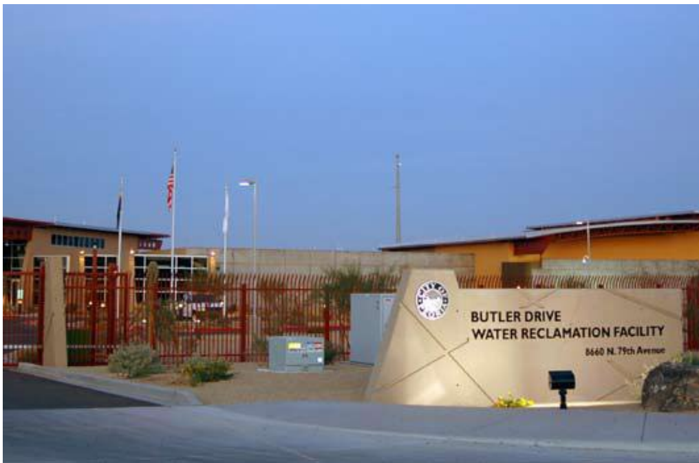
巴特勒废水回收设施：入口处
