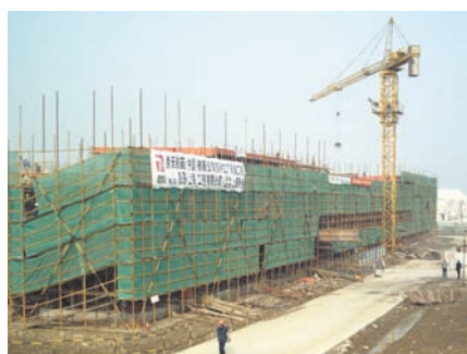
工場建設現場 2006年11月現在
