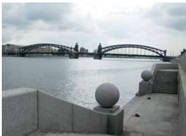
Реконструированная Смольная набережная, выполненная по проекту ЛГИП
