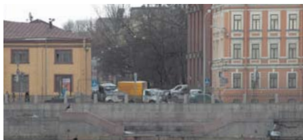
Капитальный ремонт объекта «Стенка Синопской набережной от Херсонского проезда до пирса у Большеехтинского»
