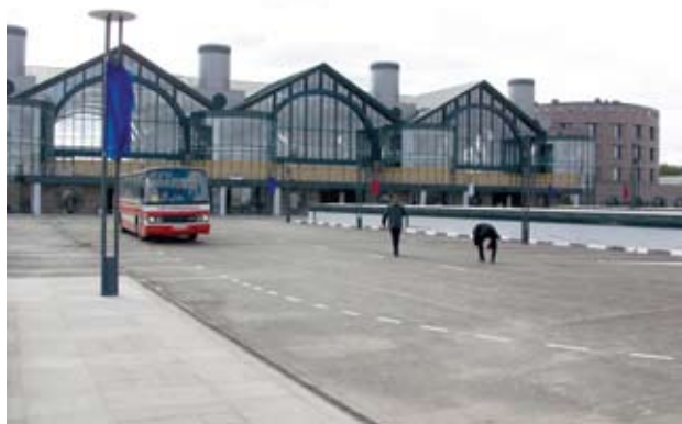
Разводка инженерных сетей Ладожского вокзала, выполненная специалистами ЛГИП
