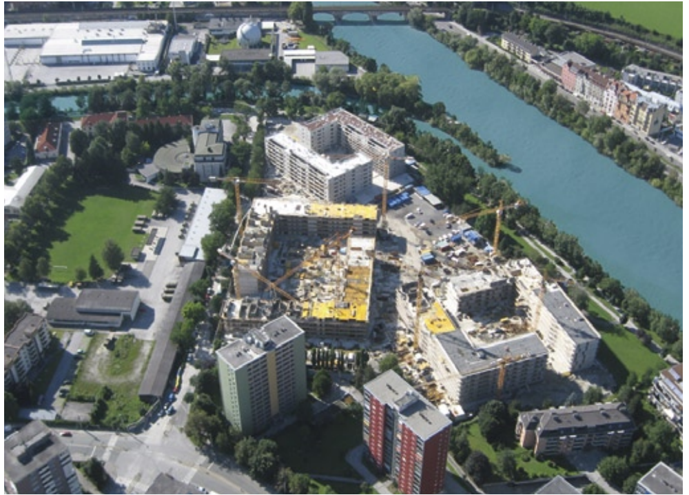
Bauphase der Wohnanlage Lodenareal in Innsbruck
